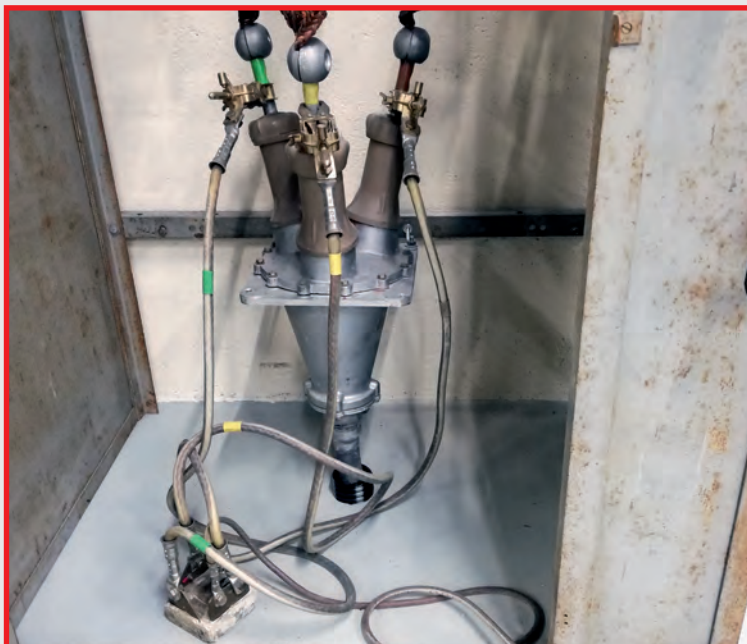
MALT/CC HTB TYPE APE SUR RÉSEAU AÉRIEN / TRANSPORT D'ÉNERGIE
