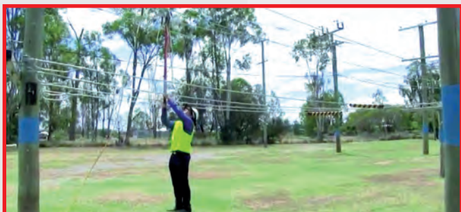
MALT/CC HTB TYPE APE SUR RÉSEAU AÉRIEN / TRANSPORT D'ÉNERGIE
