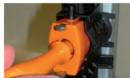
Pose d'un connecteur faux-fusible à l'aide de l'outil isolant MC-296-M
