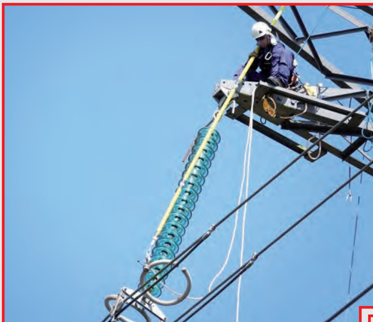
MALT/CC HTB TYPE APE SUR RÉSEAU AÉRIEN / TRANSPORT D'ÉNERGIE
