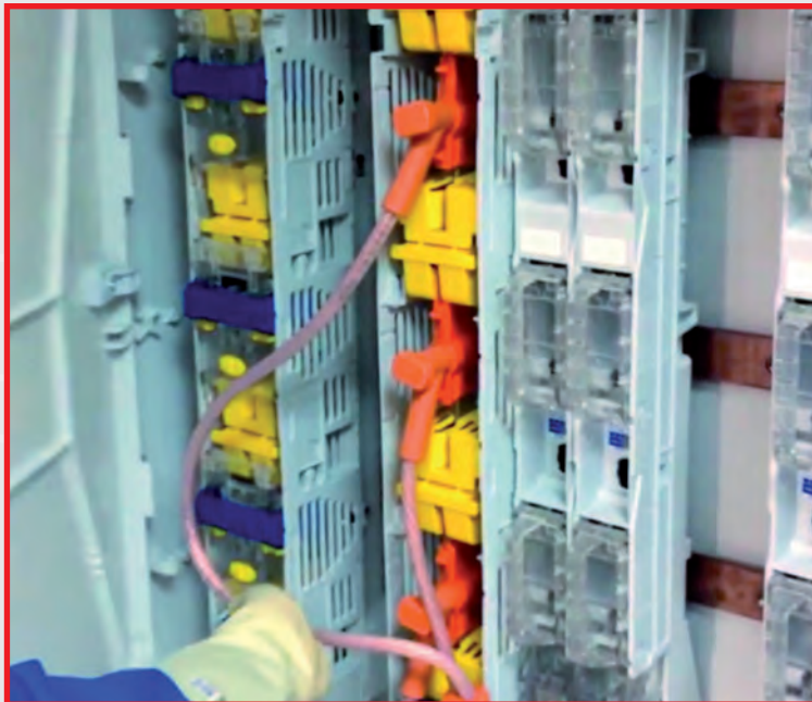
MALT/CC EN SORTIE DE TRANSFORMATEUR / INDUSTRIE
