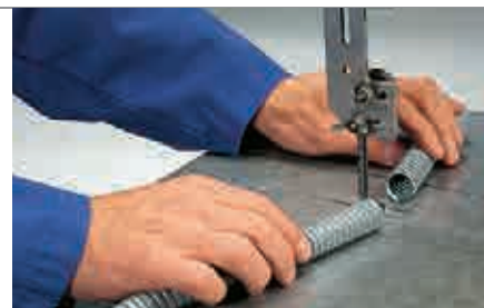
Coupe propre et extrémités de tuyau prêtes à l'emploi Conduit ends are clean and ready for use
