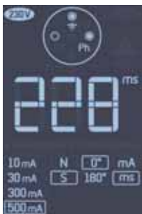
Exemple de mesure de déclenchement en valeur de temps d'un DDR 500 mA conforme.
